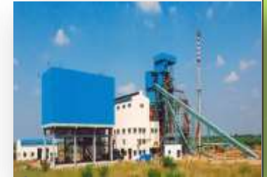
10 MW POWER PLANT FOR ETA POWERGEN
